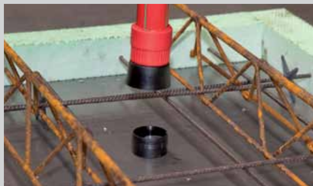
La parte superior de la salida del rociador es conectada con la base del mismo.
