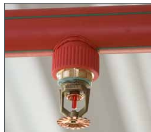
Derivación en asiento roscada. Nunca fue tan fácil instalar un rociador!!!
