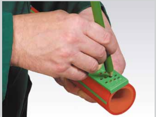
Marcar la profundidad de soldadura
