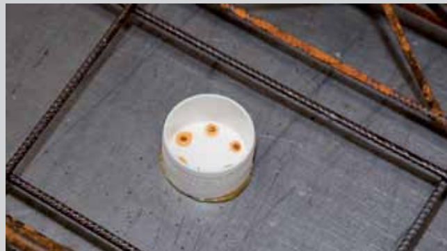
Base de la salida del rociador Art.-No. 4114190 para rociadores empotrados. Fijación mediante adhesivo en caliente.
