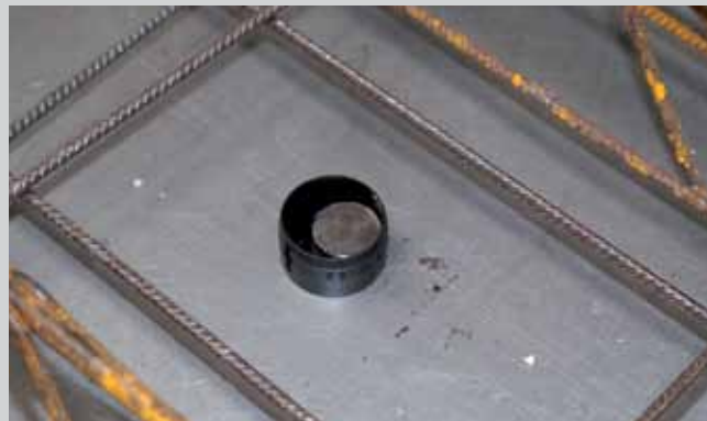
Base de la salida del rociador Art.-No. 4114180 para rociadores vistos. Fijación magnética.
